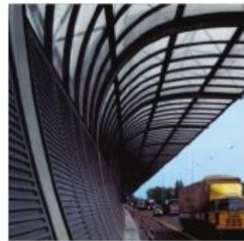
Figura 8. Detalle de la barrera voladiza.
