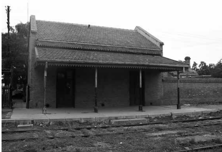
Fotos 3A y 3B. Carril Maza en Distrito de Russell y Estación de Ferrocarril en distrito de Coquimbito. Fuente: archivo documental AHTER – INCIHUSA – CONICET.
