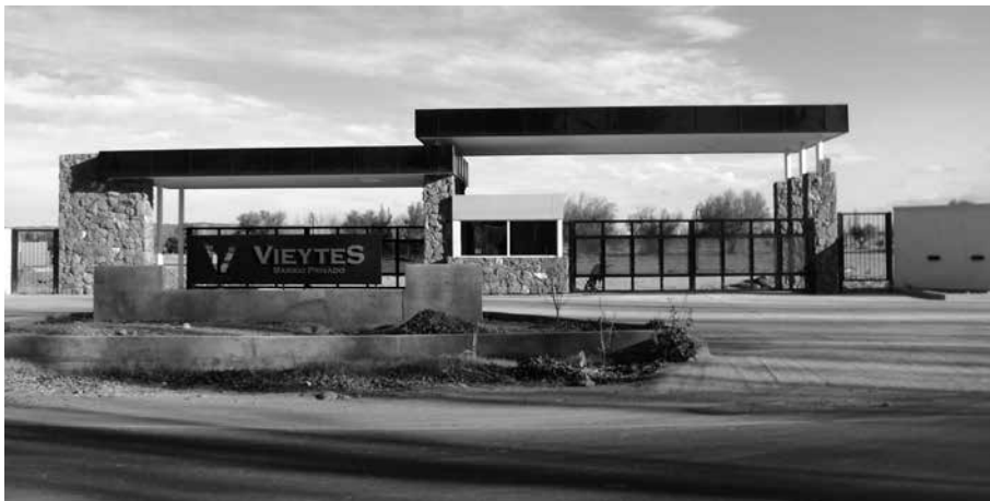
Foto 12. Portal de acceso a barrio privado en la ruta provincial N°60 en el distrito rural de Cruz de Piedra, Maipú-Mendoza, Argentina. Fuente: archivo documental AHTER – INCIHUSA – CONICET.
