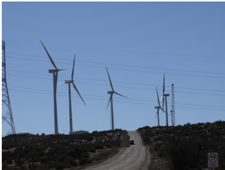
Figura 4. Aerogeneradores del Parque Eólico La Rumorosa I.
