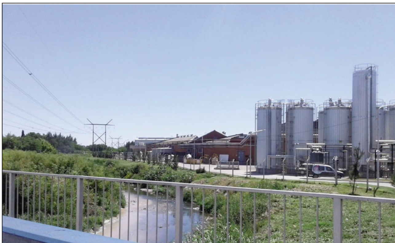
Figura 9. Vista del Parque Industrial Plátanos a orillas del arroyo Conchitas-Plátanos, sobre el cruce de la calle 41 y la calle 150 A. Fuente: Propia (21/11/2017).
