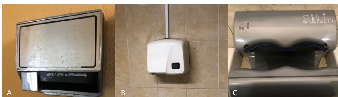
Diferentes tipos de secadores de manos. A y B. Secador de manos de aire caliente. C. Secador de manos tipo jet.
