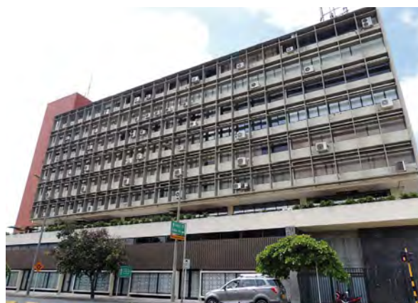
Figura 24. Edificio Belmonte, en Cali (1958).
