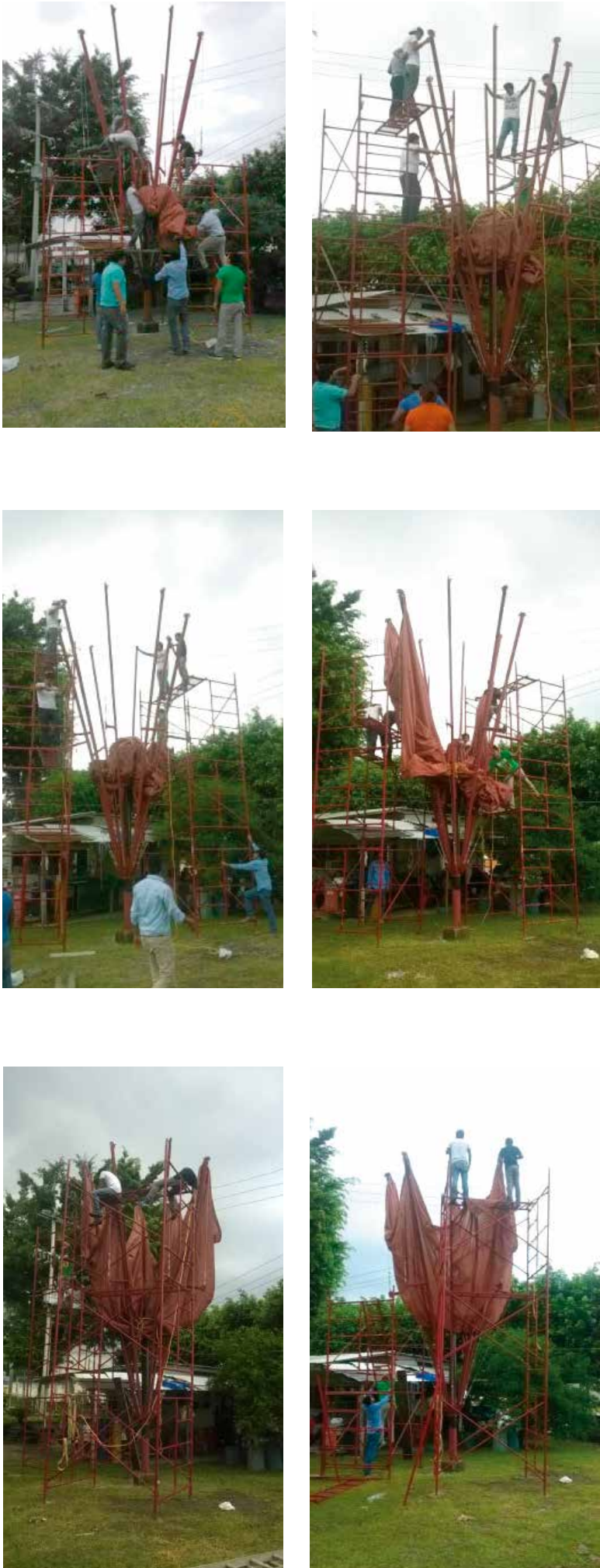
Figuras 67 a 72. Posteriormente se colocó la membrana pretensada al paraguas, con ayuda de dos andamios armados de 9 m, en cada conexión se colocó un regulador y un grillete de 1/2", que sirve de articulación flexible a la hora del despliegue Fuente: Morales (2013).
