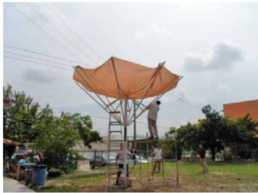
Figuras 14 a 17. Proceso constructivo del prototipo de paraguas plegable, este se desarrolló en la Facultad de Arquitectura de la UV.
