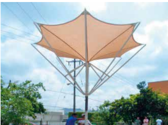
Figuras 14 a 17. Proceso constructivo del prototipo de paraguas plegable, este se desarrolló en la Facultad de Arquitectura de la UV.
