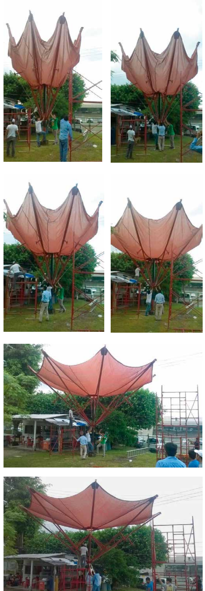
Figuras 73 a 78. Se realizó el primer despliegue del paraguas plegable con membrana; este primer intento falló porque los reguladores estaban semiabiertos y esto impidió que la membrana se tensara completamente Fuente: Morales (2013).
