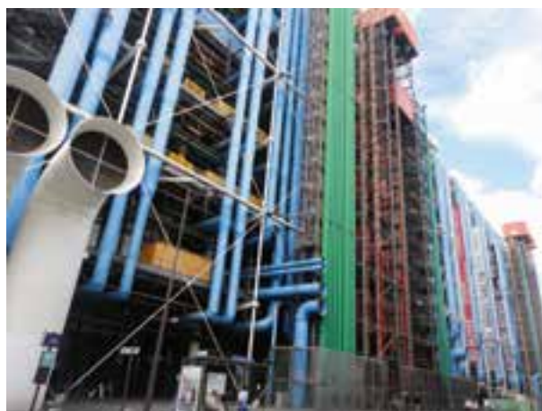
Figura 7. Centre Pompidou. Fachada posterior, sobre la rue du Renard / rue Beaubourg. Fachada posterior del Centre Pompidou, sobre la rue du Renard/rue Beaubourg, en la cual sobresalen los elementos en cuatro colores según su función: azul para instalaciones de climatización; amarillo para instalaciones eléctricas; verde para instalaciones hidráulicas; y rojo para elementos de circulación (escaleras mecánicas y ascensores).-
