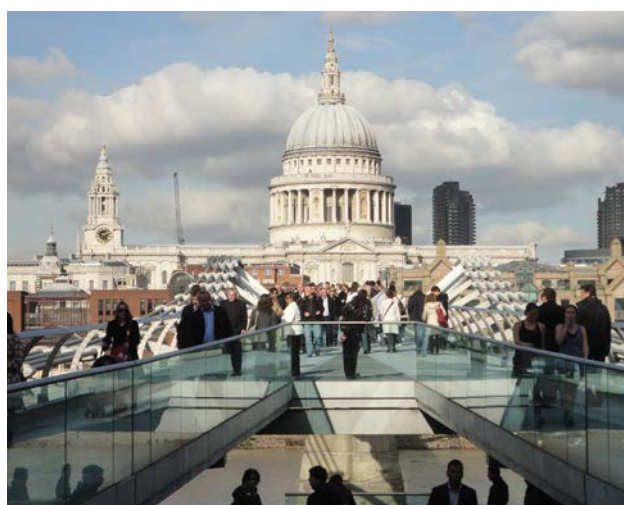
Vista del Millennium Bridge (o “puente del Milenio”) diseñado por Foster and partners en asocio con el escultor Anthony Caro y la oficina de ingenieros Arup. Inaugurado en junio de 2000, este puente colgante de 320 metros de largo conecta Tate Modern en la zona del Bankside al sur, con el distrito financiero de Londres al norte del río Támesis: en la foto se aprecia al fondo la Catedral de Saint Paul.
