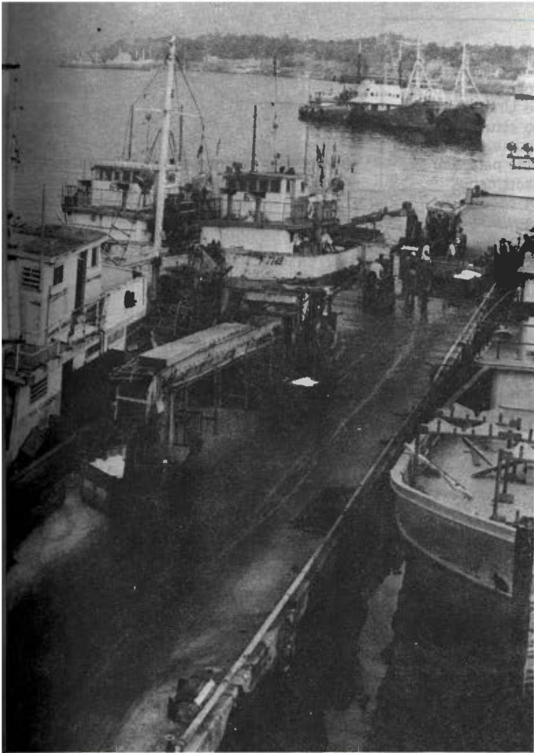
Vista parcial de los muelles de la Empresa Pesquera Industrial de Regla. Por aquí descarga su captura, fundamentalmente, la vecina Flota del Golfo
