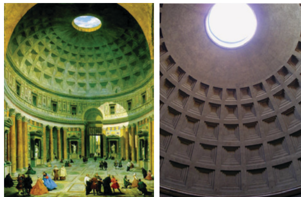
Figura 4. A la izquierda, interior del Panteón romano según grabado del S. XVIII de Panini. A la derecha, detalle actual del óculo y de los casetones.
