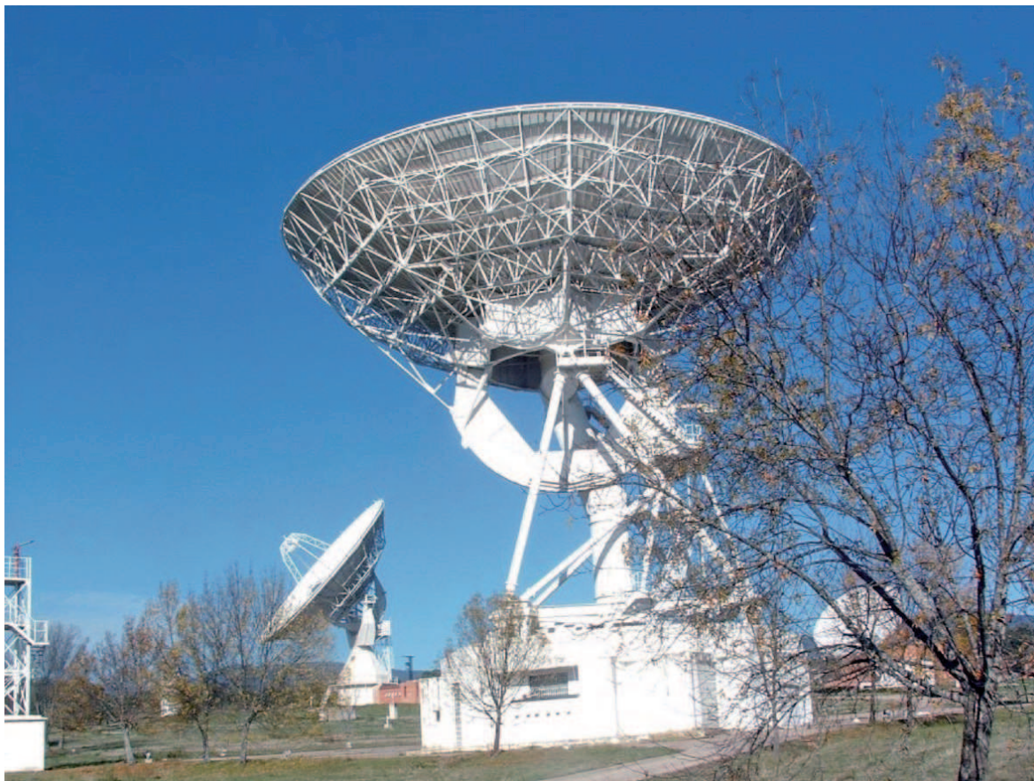
Fotografía cedida por C. García, tomada del Centro español de comunicaciones por satélite de la Compañía Telefónica de España, S.A., ubicado en Buitrago de Lozoya (Madrid) y desmantelado hace dos años, en concreto en 2003. Entre las funciones de este centro, se encontraban las destinadas al control y cuidado del medio ambiente.
