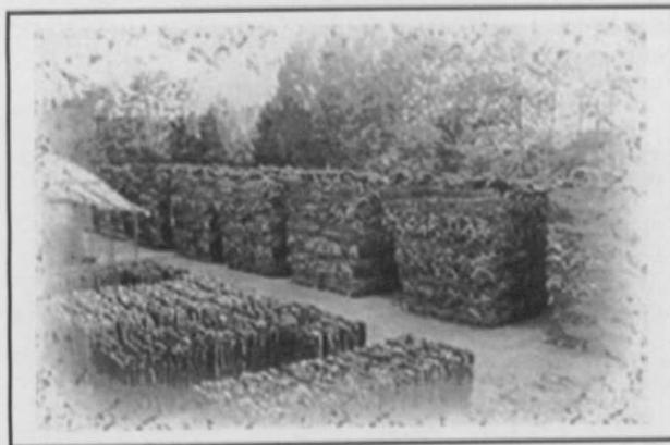
Las planchas de corcho se almacenan y se dejan reposar para su desecación. Cuando han perdido su humedad natural se pasan al proceso de *Cocido* donde el corcho es vaporizado y hervido en autoclaves o calderas de acero inoxidable.
