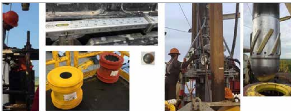
Figura 4. Equipo para la corrida y accesorios utilizados para la cementación de la tubería de revestimiento de 16” 3
