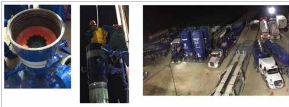
Figura 3. Equipo para la corrida de la tubería y accesorios utilizados para la cementación de la tubería de revestimiento de 20” 3 .
