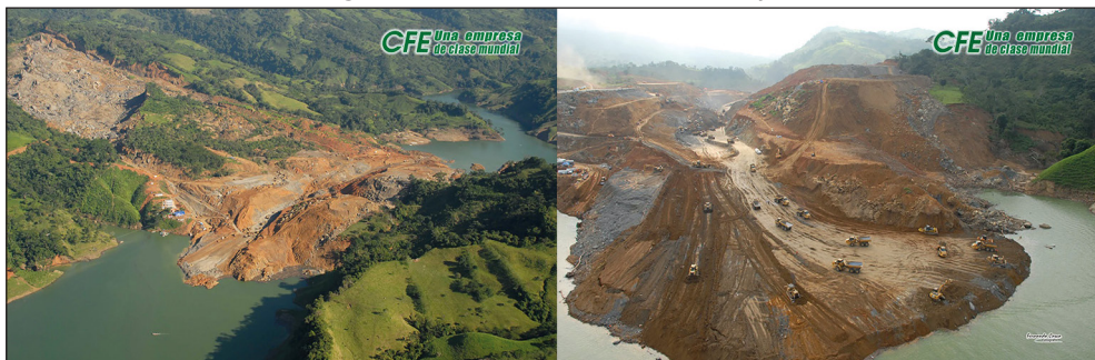
Imágenes 1. Deslizamiento del río Grijalva
