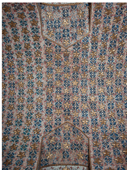
Figura 1. Detalle de la bóveda de la iglesia de Santa Clara
