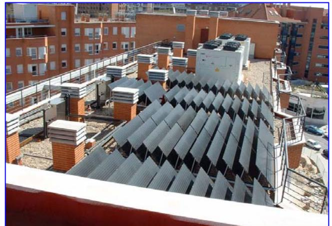
En este punto, el compresor del bloque, mediante presión, eleva la temperatura del fluido entre  $110^{\circ}\text{C}$  y  $120^{\circ}\text{C}$ , la que es transmitida al circuito de agua mediante un intercambiador de temperatura. Los componentes principales de una instalación solar termodinámica son los captadores solares, el compresor, el condensador y la válvula de expansión. Los diferentes elementos están unidos entre sí mediante tuberías de cobre deshidratado.
