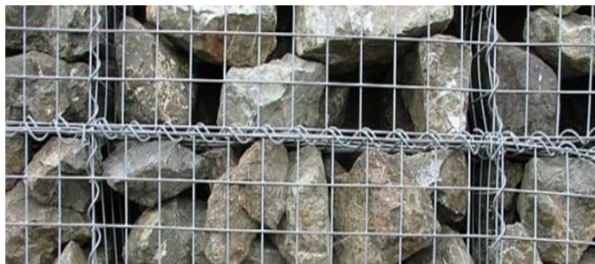
Sistema de gaviones en Las Bodegas Dominus. Fuente: [13]
