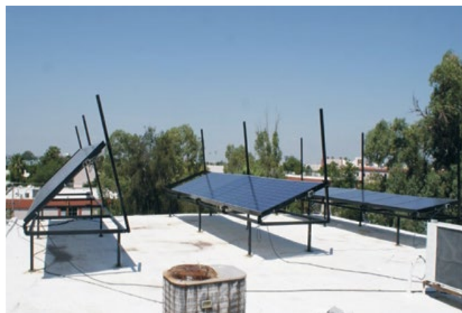
Figura 1. Secciones del arreglo fotovoltaico con diferentes ángulos de inclinación.
