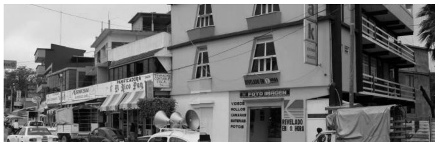
Figs. 1, 2 y 3. Vista de la avenida Juárez, vía primaria de la ciudad de Palenque. La rehabilitación de esta avenida se consideró en el proyecto original, pero la construcción no se llevó a cabo.
