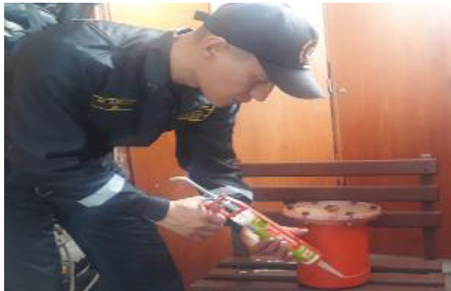
Figura 15. Impermeabilización tapa inferior
