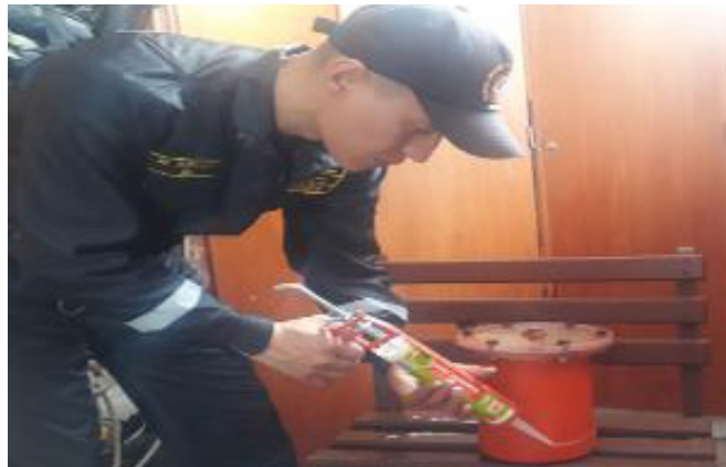
Figura 15. Impermeabilización tapa inferior
