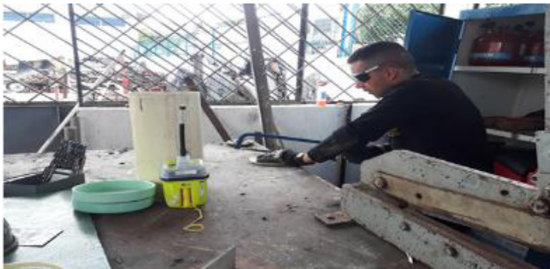
Figura 12. Fabricación elemento protector- tubería PVC Fuente: Autores
