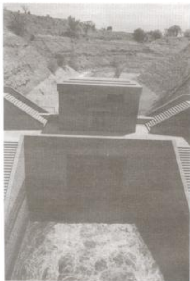
Fotografía del Nuevo Túnel mostrando las compuertas de la presa que regula la entrada del agua del Gran Canal a la boca del túnel. AHA, Colección fotográfica, c. 598, exp. 23415, f. 1.
