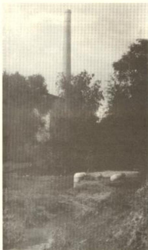
Presa junto a la planta Electra Manuela, San Luis Potosí (1942), AHA, Aprovechamientos Superficiales, caja 1290, exp. 17711, f. 243.
