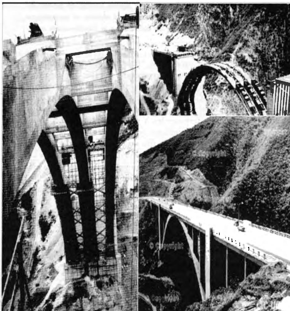
Figura 5: Composición donde se aprecian diferentes momentos de la construcción del viaducto 1 y su estado recién inaugurado. Fuentes de las imágenes: Revista Shell, N° 3, 1952, para las etapas de su construcción, y Archivo Fotográfico Shell del Centro de Investigaciones de la Comunicación de la Universidad Católica Andrés Bello para la imagen del puente ya culminado.
