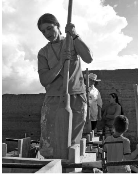
Figura 18: Imagen de tapiera beneficiaria en Sonsón, Antioquia. Implementación de tapiál más liviano y con menos piezas móviles.
