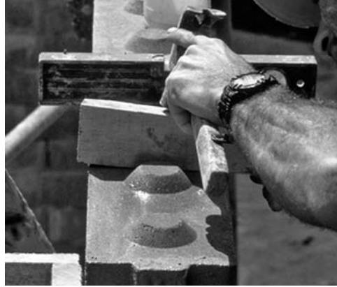
Figura 4: El bloque dotado de nervaduras y refuerzos, fabricado con la prensa GEO 50 modificada.
