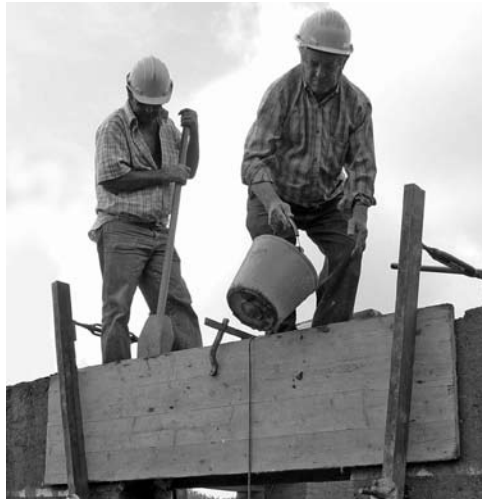
Figura 10: Construcción de una vivienda de tapia. Alentejo, Portugal.
