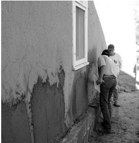
Figura 5: Pruebas comparativas de revestimientos de barro. San Ysidro, New Mexico.
