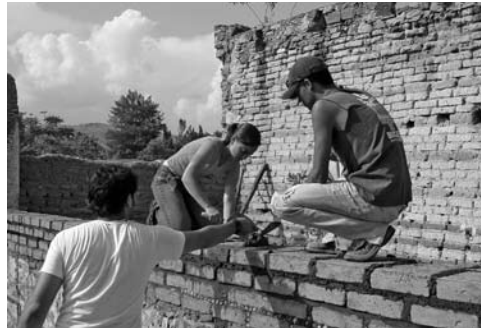
Figura 9: Elaboración de un muro de adobe colocado en sogá. Aguascalientes, México.
