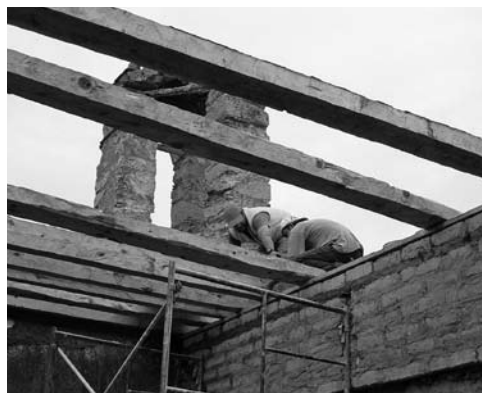
Figura 13: Colocación de las vigas de la cubierta sobre el tablón collar o arrastre. Restauración del templo de Chalchihuites, México.
