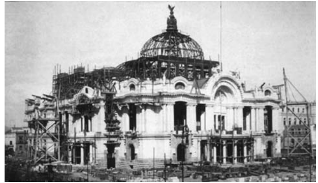
Figura 6: Adamo Boari, Teatro Nacional, México D. F., 1904-1916 (1934). Proceso de construcción. Fuente: García, G. (1991).
