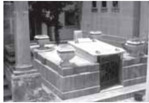
Figura 12: Plataforma sencilla con cripta, acceso al frente (cantería y tapa de mármol) (13.7).
