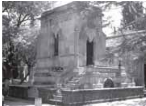
Figura 22: Capilla ecléctica con elementos góticos y románicos (cantería). Tiene escaleras laterales y respiraderos y está desplantada sobre una plataforma que presenta el acceso lateral a la cripta (2.1).
