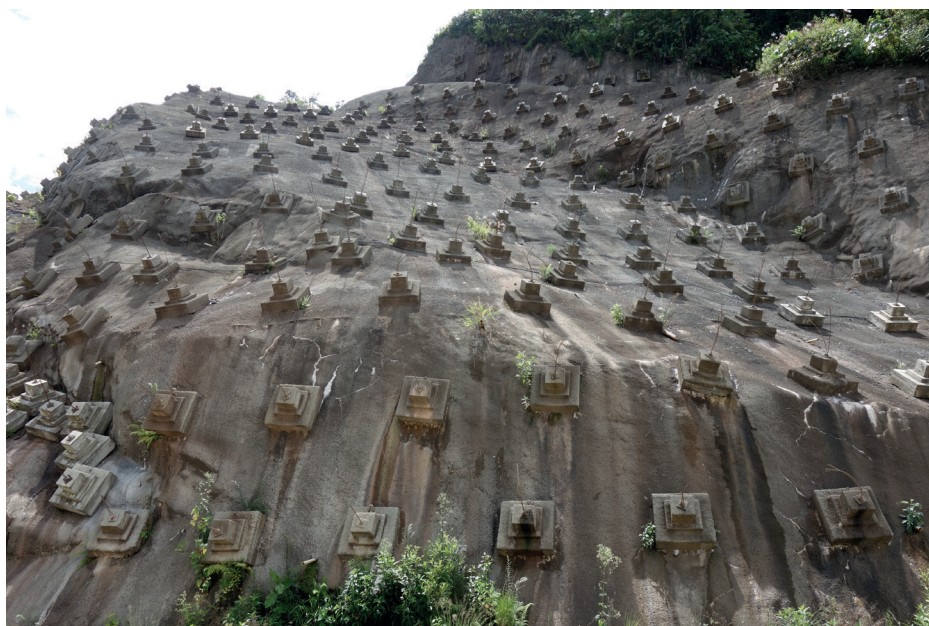
Figura 9. Muro en concreto proyectado de anclajes activos
