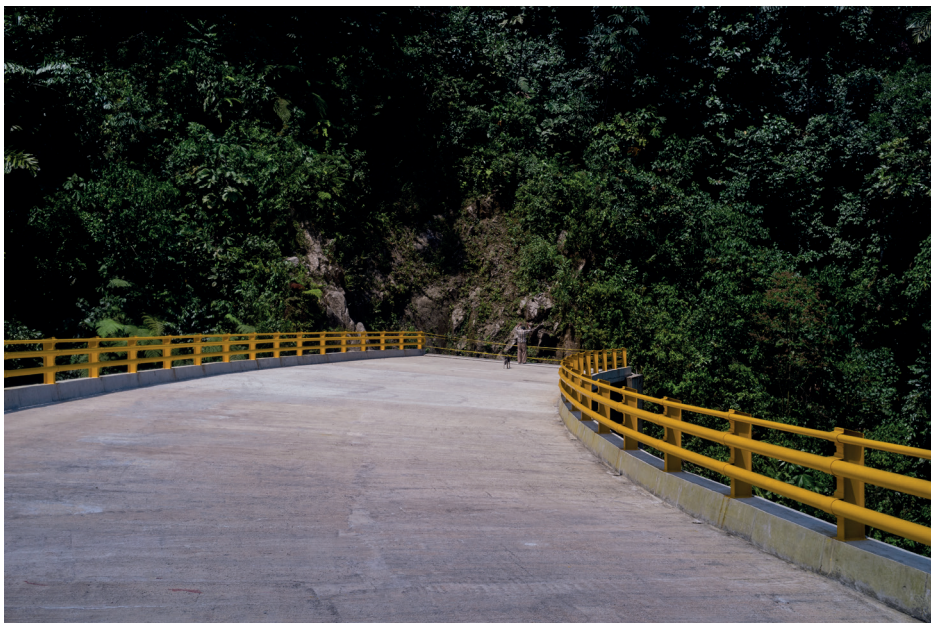
Figura 5. Extremo oriental del puente Campucana
