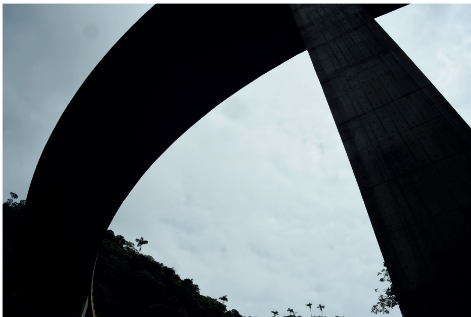
Figura 2. Puente Campucana, plano contrapicado
