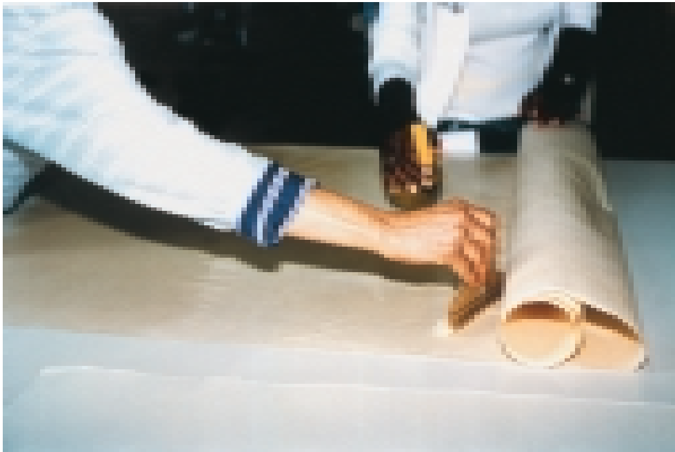
FIGURA 7 – Aplicação de umidade para planificação do papel japonês empregado na velatura. Fotografia de José Rosael.
