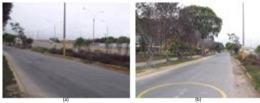
Figura 6. Estado del cerco perimétrico, como vemos ambos casos, es casi nulo.
