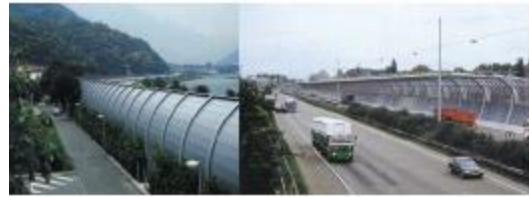
Figura 8. Vista de la barrera acústica.
