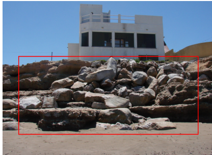
Figura 6. Calles que finalizan en la barranca
