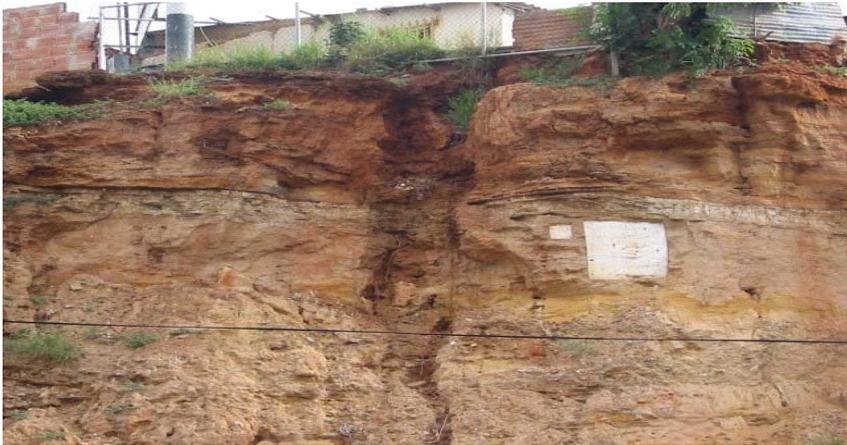
**Figura 3.** Cárcavas por infiltraciones en zanjas no revestidas
