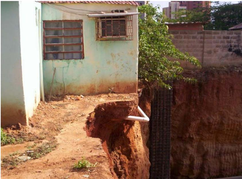
**Figura 7.** Excavaciones artificiales que generan derrumbes y deslizamientos
