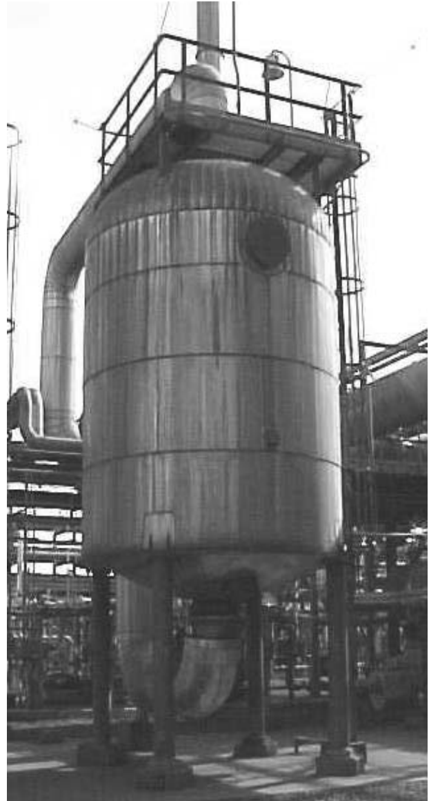
Figura 3 Shift Reactor (Reactor Convertidor) de CO de Orinoco Iron Fuente: Duran, 2004:s.p.
