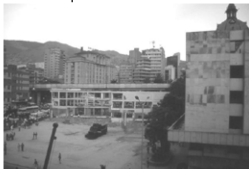
Foto 6. Construcciones demolidas en la actual Plaza de las Esculturas. MA/PE-1999/2000, d
