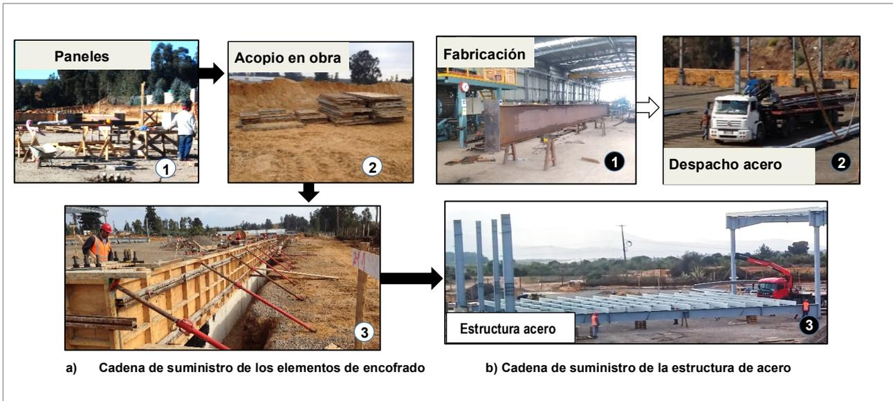
Figura 3. Cadenas de suministro para las fundaciones de hormigón y la estructura de acero
