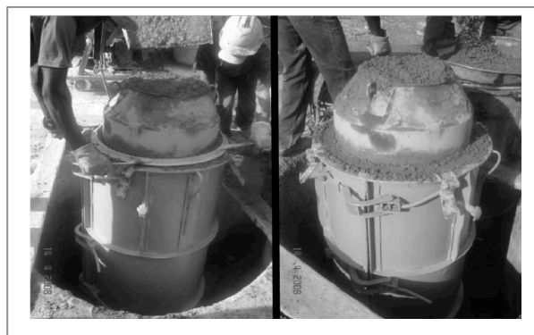
Figura 2. Densificación del hormigón mediante sistema de producción vibratorio
