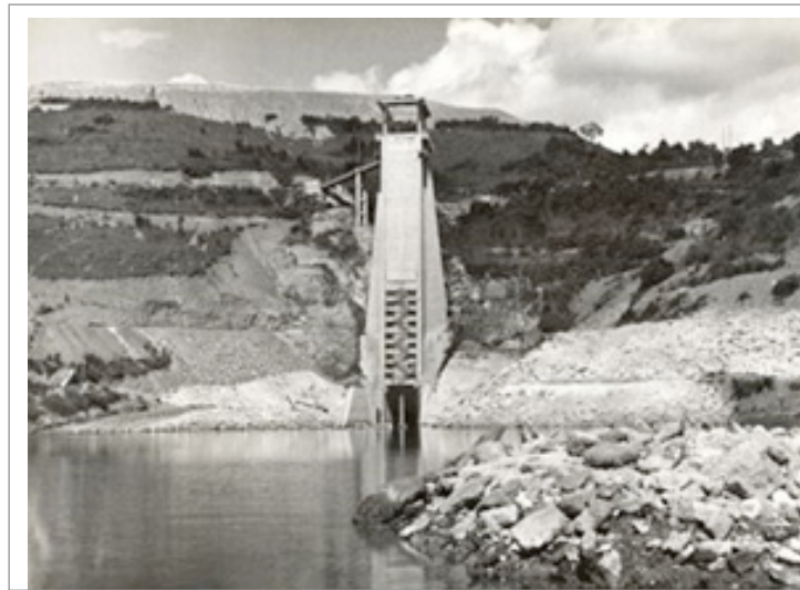
Figura 9. Entrada de agua en la PH de Jaguari (vista frontal), en la etapa final de la construcción Figure 9. Water intake of UHE Jaguari (front view) at the final stage of construction
