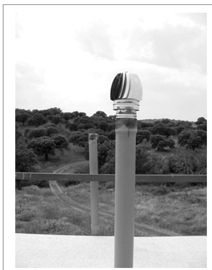
Figura 15. En esta fotografía se encuentra abierto el tiro de la arqueta situada bajo el módulo mientras que el otro tubo está sellado Figure 15. This picture shows SUMP opened draught located underneath the modulus, while the other tube is sealed
