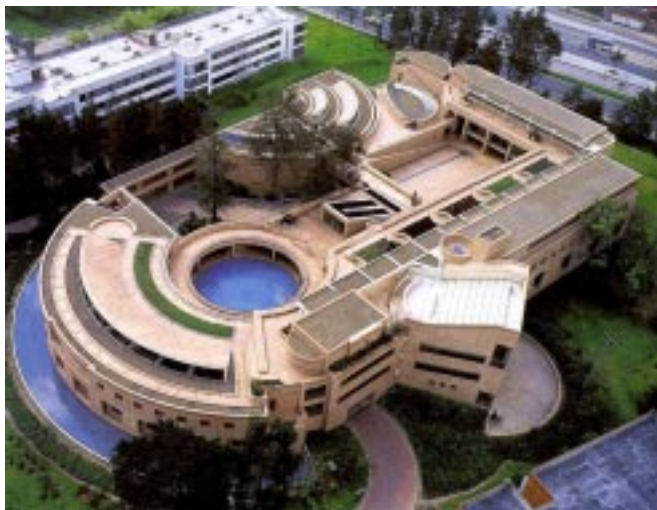
Edificio de Postgrados Universidad Nacional de Colombia
