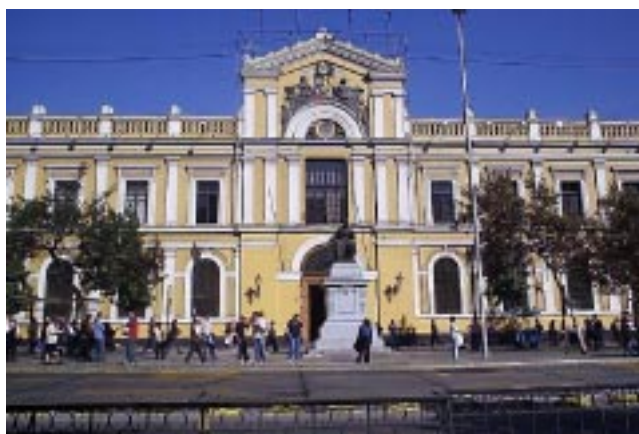
Detalle Edificio Universidad de Chile
