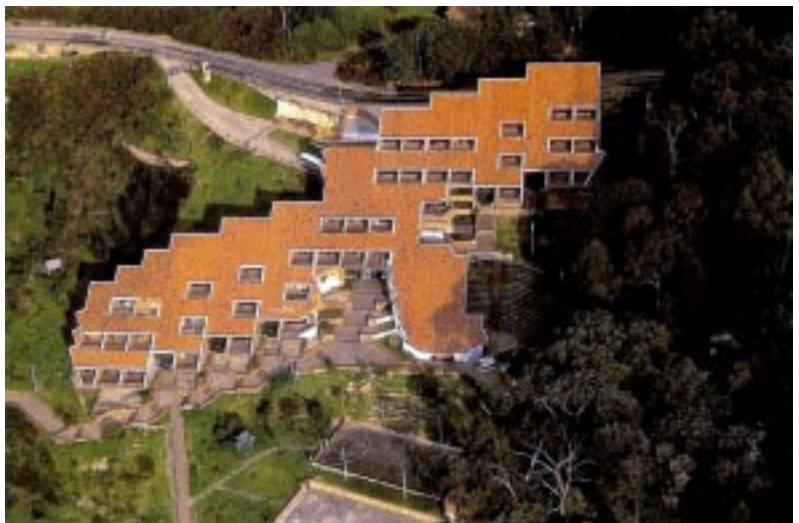
Edificio Sede La Macarena Universidad Distrital Francisco José de Caldas Bogotá
