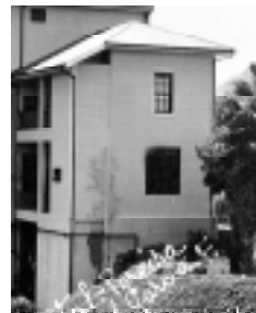
Detalle Edificio Pereira - Risaralda
