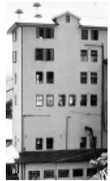
Detalle Edificio Pereira - Risaralda
