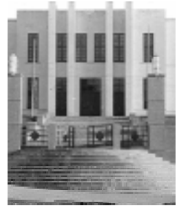
Detalle Edificio Santos Pereira - Risaralda
