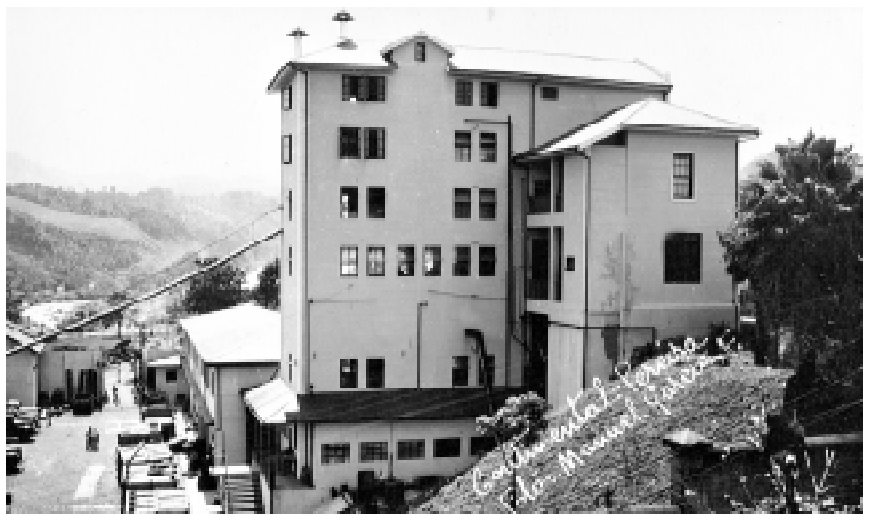
Detalle Edificio Pereira - Risaralda
