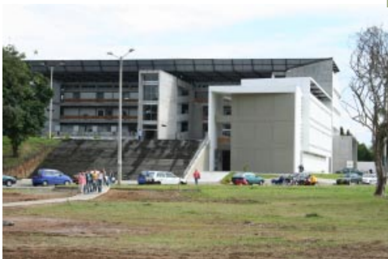
Edificio Universidad Tecnológica de Pereira
