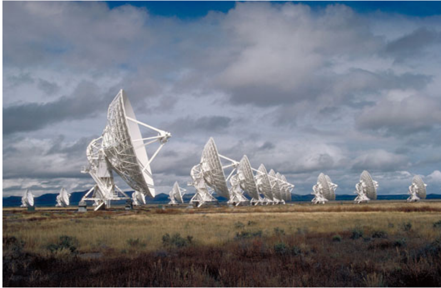
Figura 2. El interferómetro de radio VLA, en las planicies de San Agustín, New Mexico, EUA. Está constituido por 27 platos, cada uno de 25 metros de diámetro que pueden separarse hasta por 35 kilómetros. En esta imagen solo se ven algunos de los platos.
