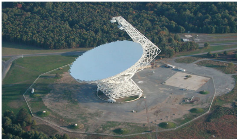
Figura 1. El radiotelescopio de Green Bank, en el estado de Virginia Occidental, EUA, tiene un diámetro de 100 metros. Este es el tamaño más grande que se ha logrado alcanzar para radiotelescopios de un solo plato que tengan la capacidad de moverse y apuntar cualquier región del cielo.
