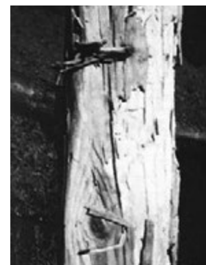
Figura 3. Madera atacada por el carcoma grande o capricornio de las casas. Fotografía reproducida de Di Battista (1989).
