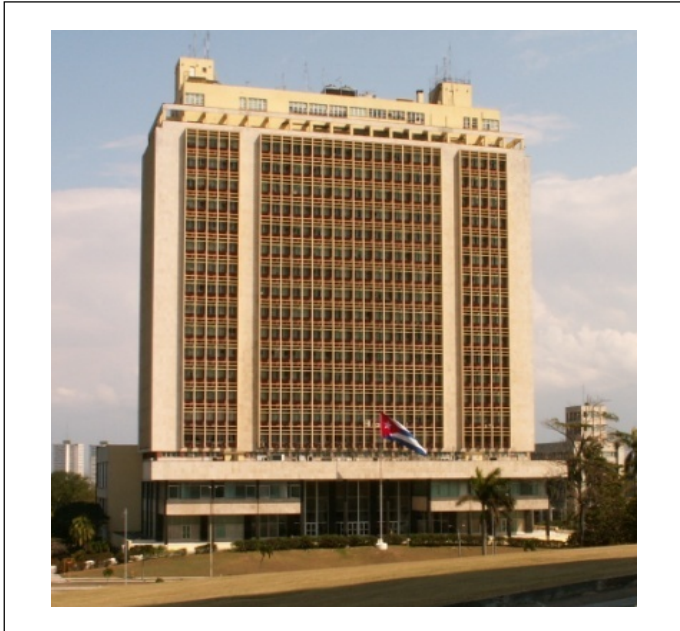
Fig. 3. Edificio sede del MINFAR, de 24 plantas (94 m de altura), primero de su tipo construido sobre cimiento laminar. Vista actual.
