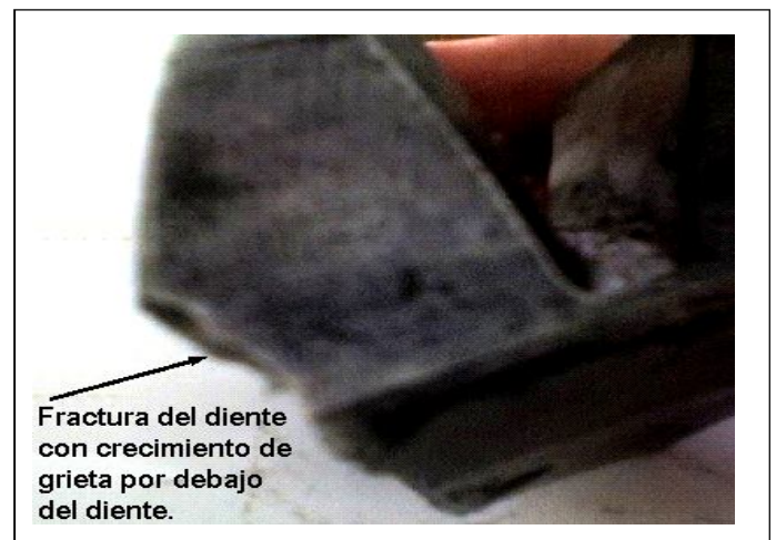
Fig. 4. Clásica fractura de rueda cónica por insuficiente espesor de llanta para soportar las cargas de trabajo. Notar que la grieta no crece a lo ancho de la base del diente.
