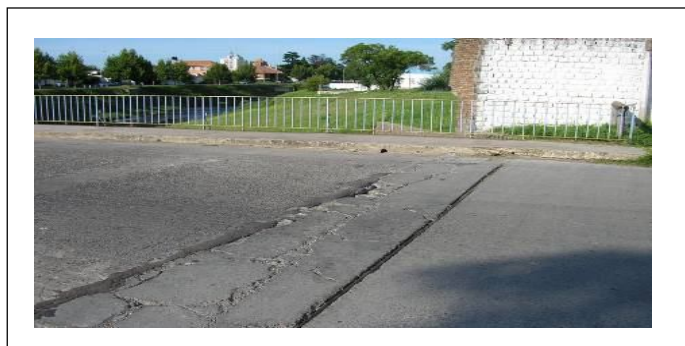
Fig. 6. Fisuras sobre el tablero.
