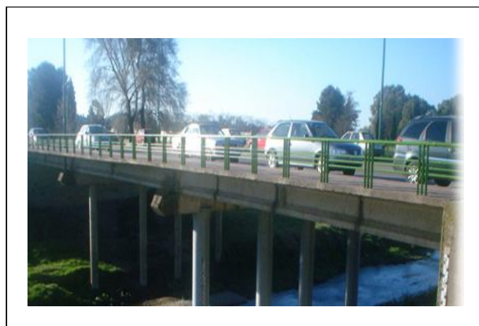
Fig. 3. Vista del puente Trabajadores.
