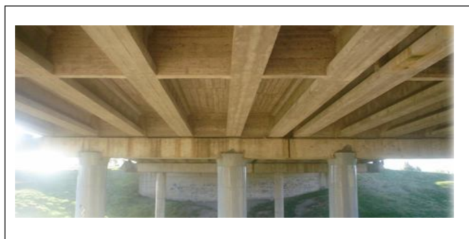
Fig. 4. Tipología estructural del puente Trabajadores.
