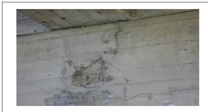
Fig. 5. Vistas del estribo N-O.
