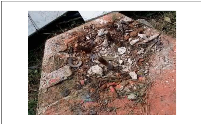
Fig. 13. Condición en que quedaron los pernos de la base A y C de la torre (proporcionado por ETECSA).
