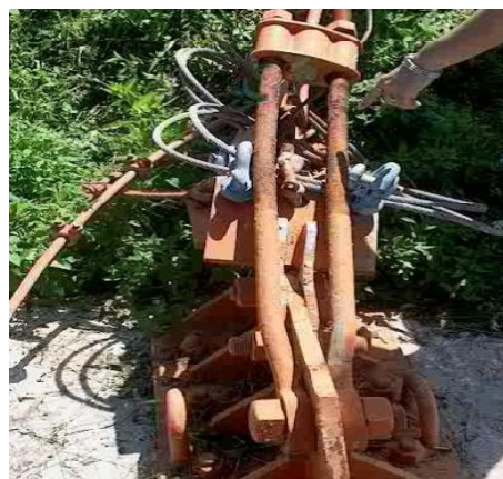
Fig. 11. Anclaje C visto desde otro ángulo (proporcionado por ETECSA).
