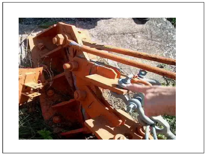
Fig. 7. Anclaje A al mismo nivel de la base de la torre (proporcionado por ETECSA).
