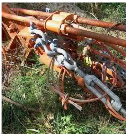
Fig. 9. Anclaje B a 10 m por debajo de la base de la torre (proporcionado por ETECSA).
