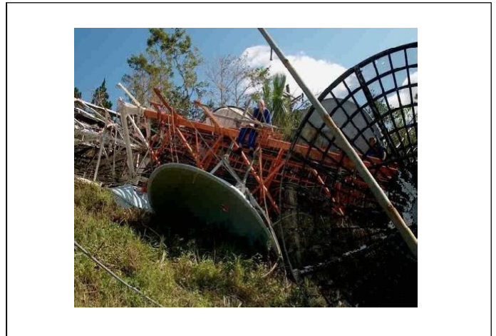
Fig. 6. Presencia de grandes antenas en la torre.
