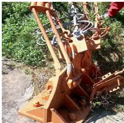
Fig. 8. Anclaje A visto desde otro ángulo (proporcionado por ETECSA).
