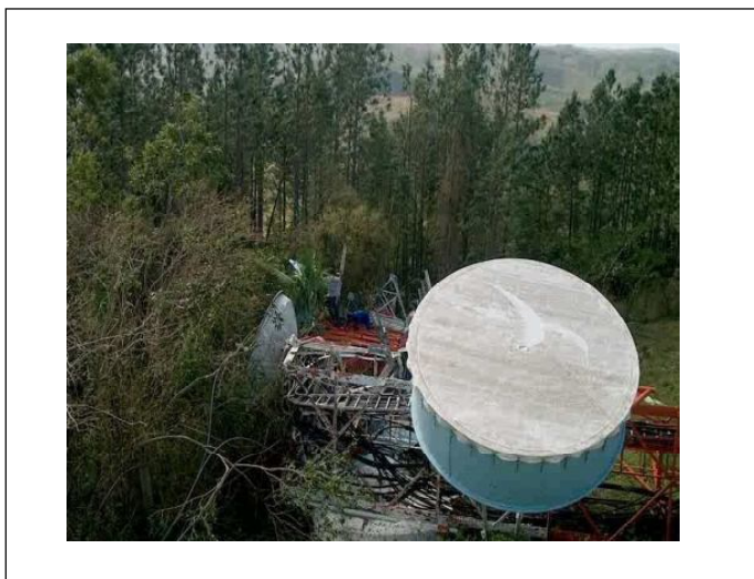
Fig. 5. Caída de la torre Jacán ladera abajo.
