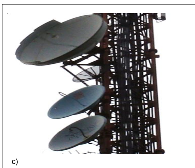
Fig. 17. Tipos de antena: a) Antenas UHF; b) Antenas VHF; c) Parábolas.
