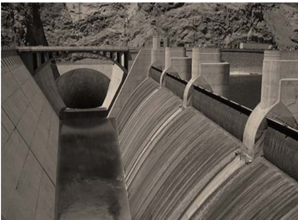
Figura 1 – Vertedouro lateral na barragem Hoover – Lago Meads, Boulder City, Nevada – USA
